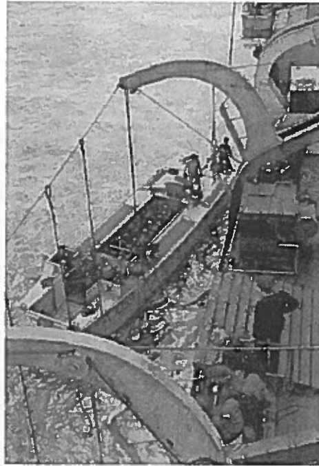
Mise à la mer des péniches de débarquement
