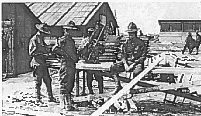
Sammies affectés à la construction de leurs baraquements. Source : US Army
