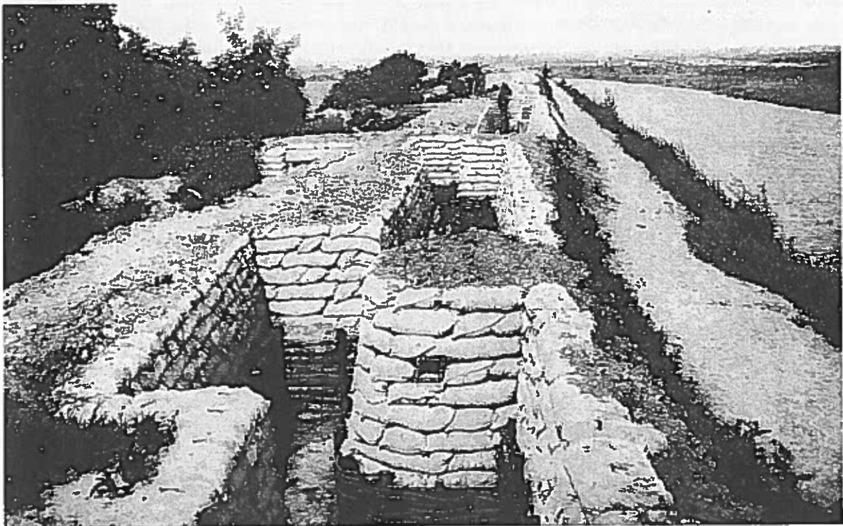
Carte postale d'après-guerre du Boyau de la Mort, à Dixmude. On peut voir la faible largeur de l'Yser en cette portion du front et les fréquentes chicanes qui compartiment la tranchée pour minimiser les effets des explosions ou compliquer la tâche des assaillants. Collection privée, Mme Thérèse Deleruelle. ©
