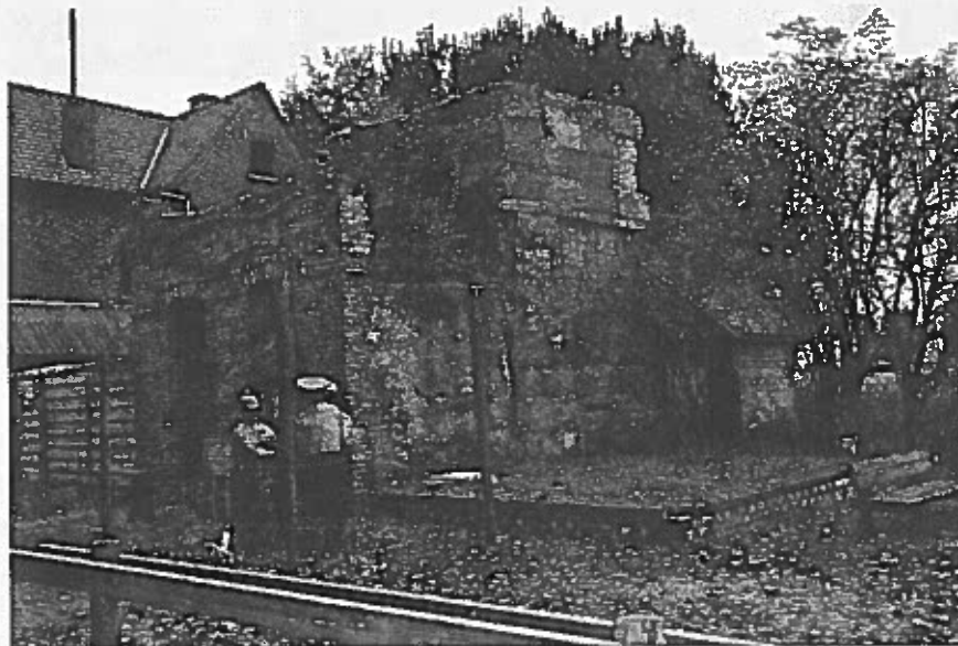
La gare de Ramskapelle (ou ce qu'il en reste) le long de l'ancienne ligne de CF Nieuport – Dixmude
