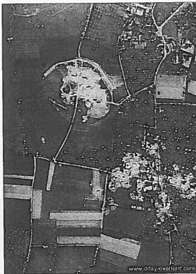
Vue aérienne de la batterie de Merville construite par l'organisation Todt
