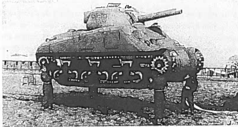
Un char gonflable représentant un char Sherman M4 et supposé tromper les missions de reconnaissance aérienne allemande dans le cadre de l'opération Fortitude. Photo : IWM
